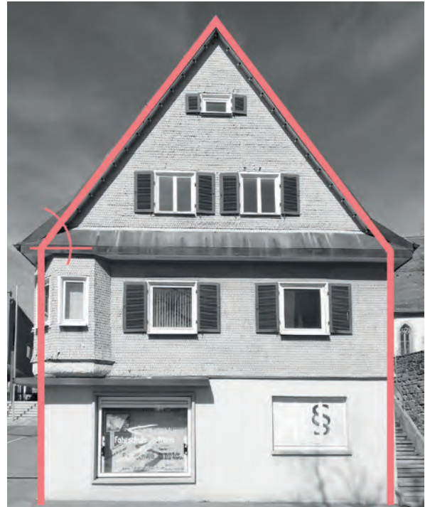
Gebäude mit prägender Giebelproportion
