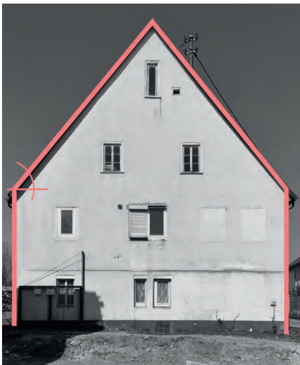
Gebäude mit prägender Giebelproportion
