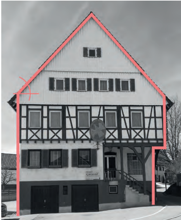
Gebäude mit prägender Giebelproportion
